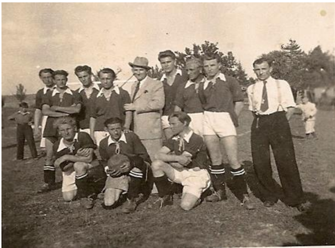
Zakladateľ organizovaného futbalu v Zemianskych Kostolňanoch Gejza Kapusta (v strede v klobúku)
